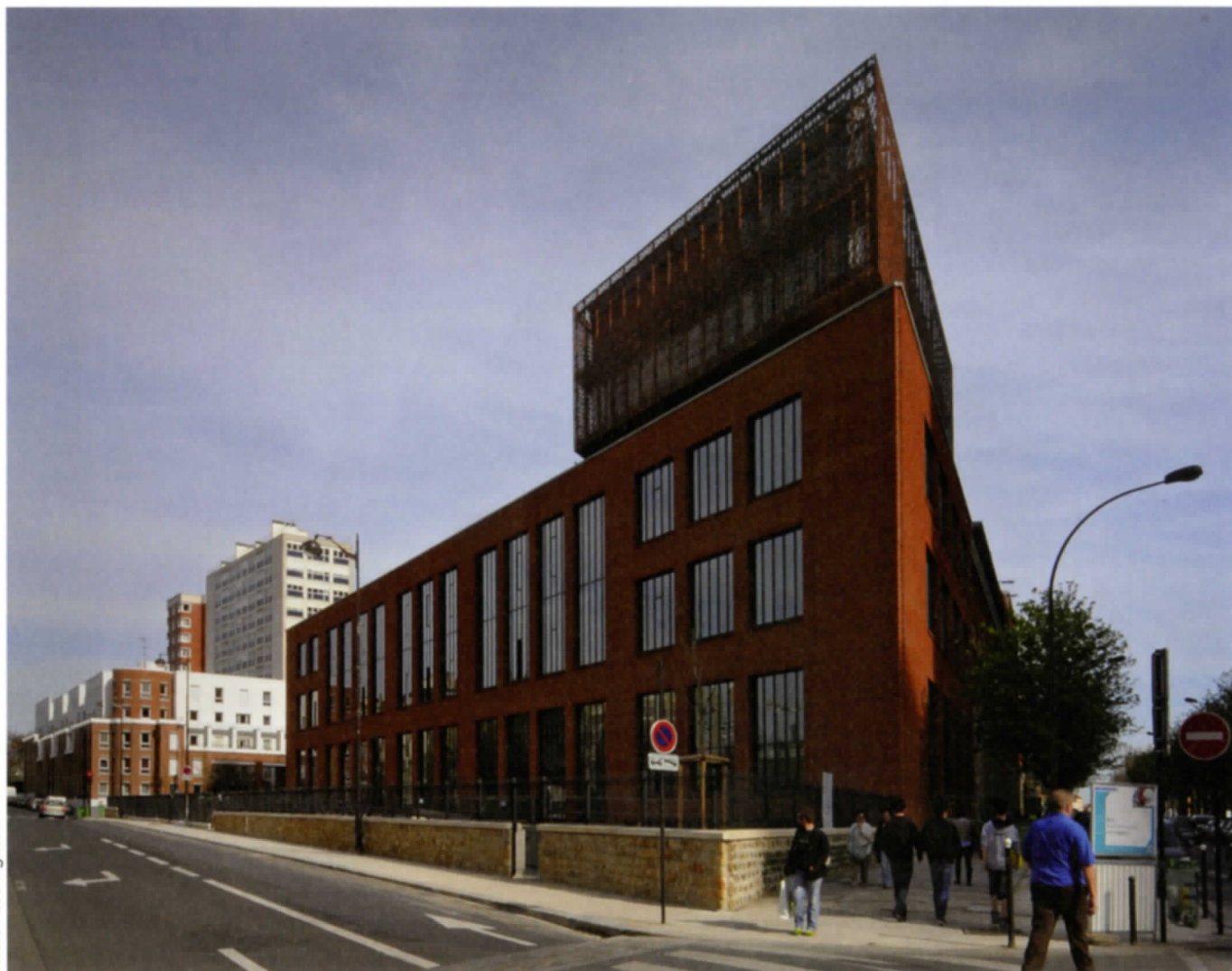
Usine Panhard & Levassor reconvertie en pôle tertiaire ; architectes : Arep. Des bureaux et l'agence d'Arep occupent cette ancienne usine surélevée de trois niveaux, tel un « container » bardé d'acier perforé et thermolaqué. Des bureaux et des espaces communs occupent les volumes diversifiés sous les sheds en acier (photo ci-dessous).
